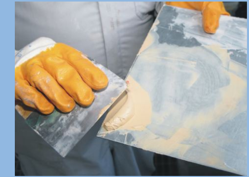
Spachtelmasse homogenisieren
